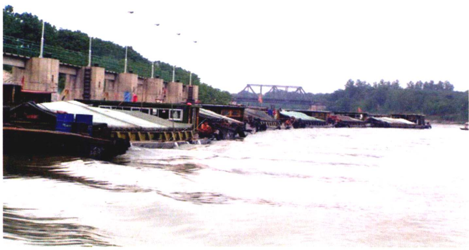
京杭运河旅游带掠影：济宁韩庄船闸泊船区一角
