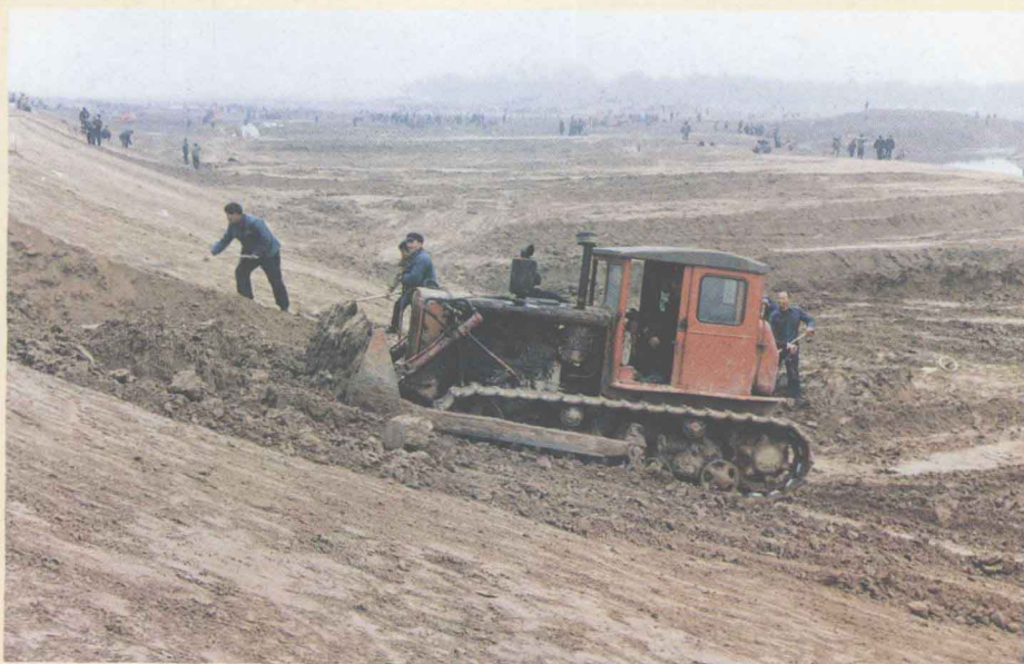
即将竣工的贾鲁河治理工程
