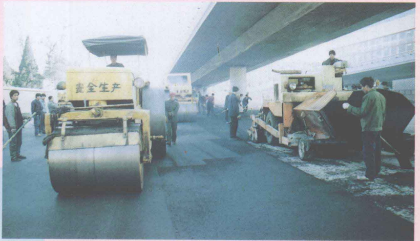
市政管理处修建公司正在加紧施工维修道路
