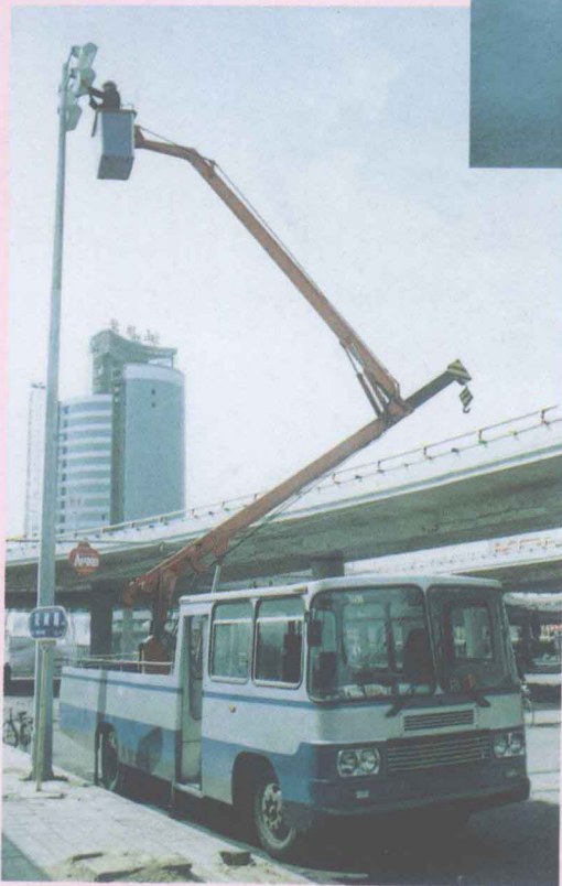
路灯管养所正在主次干道维修路灯
