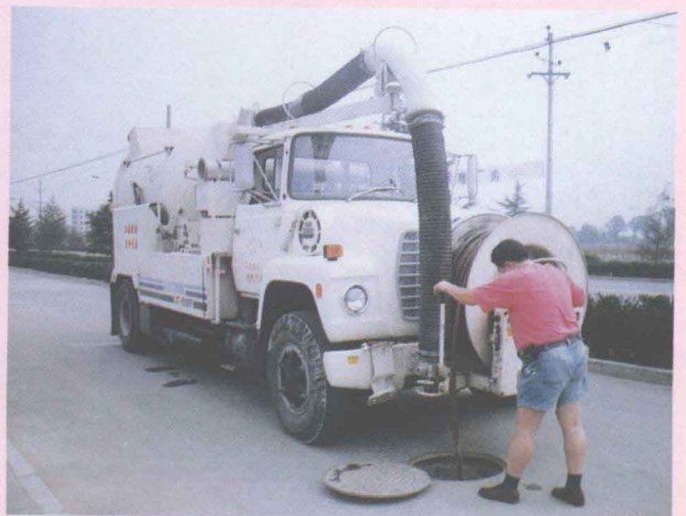
从美国引进的现代化疏通下水管道车正在作业
