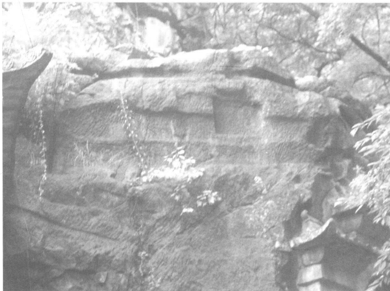
图2 第19窟外岩壁上的凹槽与榫孔遗迹
