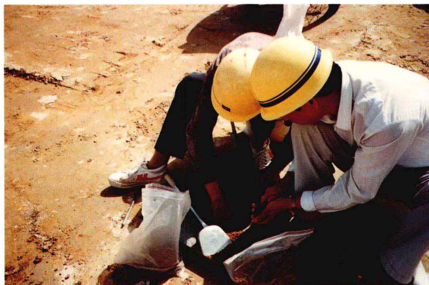
换砂法测定回 填土密实度
