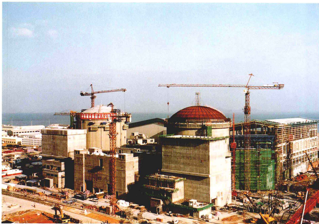
2000年1月建设中的岭澳核电站
