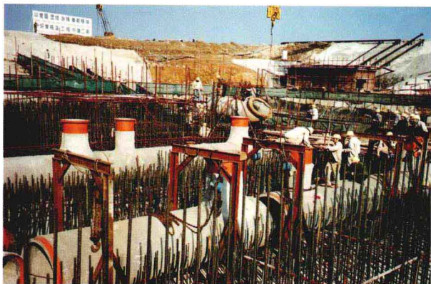
水泵房 SEC 管安装
