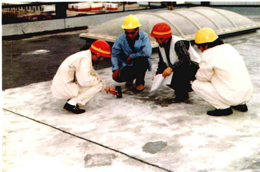
测定防水基层 的含水率
