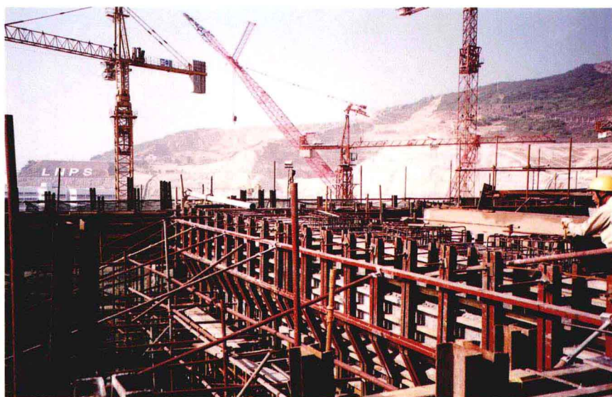
常规岛 BC 列框架 花篮梁模板
