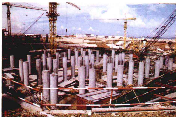
2号常规岛挖孔桩显露地上的桩林
