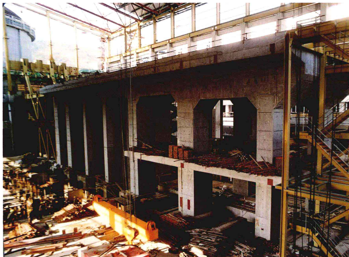
常规岛主钢结构防甩击大件吊装(2)
