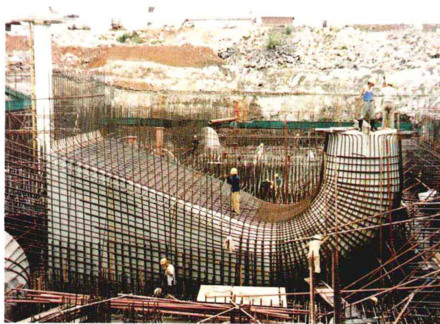
进水道钢筋绑扎
