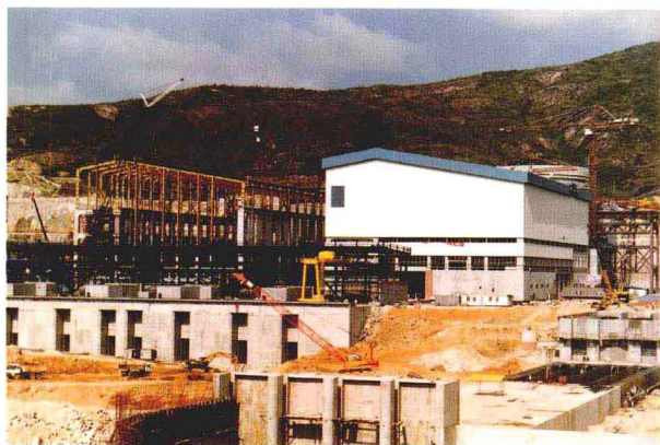
施工中的常规岛厂房
