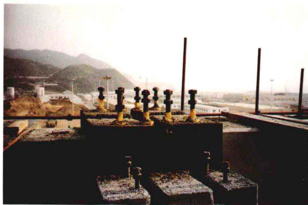
常规岛柱头预埋螺栓
