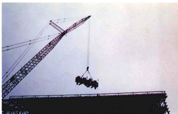
常规岛主钢结构防甩击大件吊装(1)
