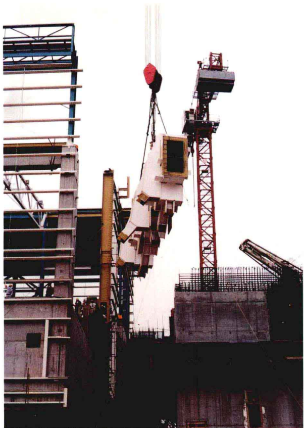
常规岛主钢结构防甩击大件吊装(2)
