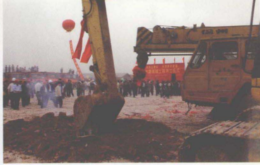
金水东路破土动工
