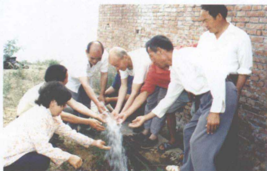
王屋山供水工程通水后,群众迫不及待地分享通水的欢乐
