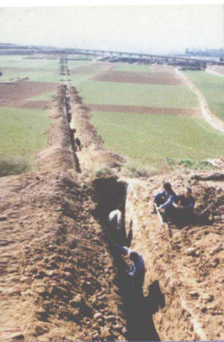
供水工程建设中,数万群众投入工地,开挖管槽,参加建设
