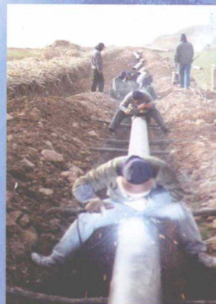
王屋山供水工程管道铺设施工现场
