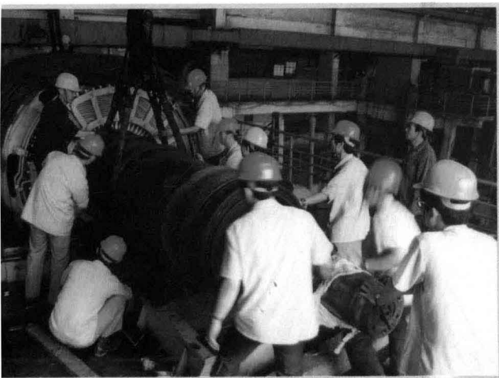
大修中吊装发电机转子。
