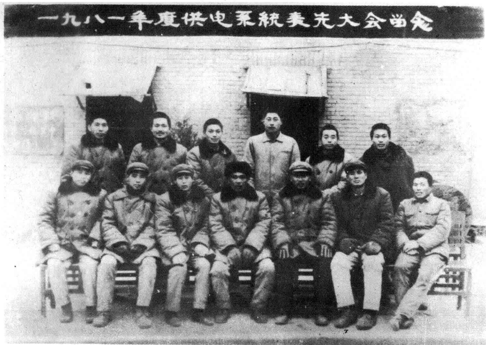
13 一九八一年度市供电系统表先大会代表（机电安装公司）
