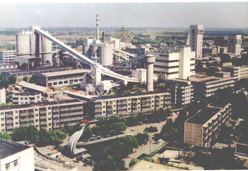
运河畔的煤炭基地兖州矿业集团总公司
