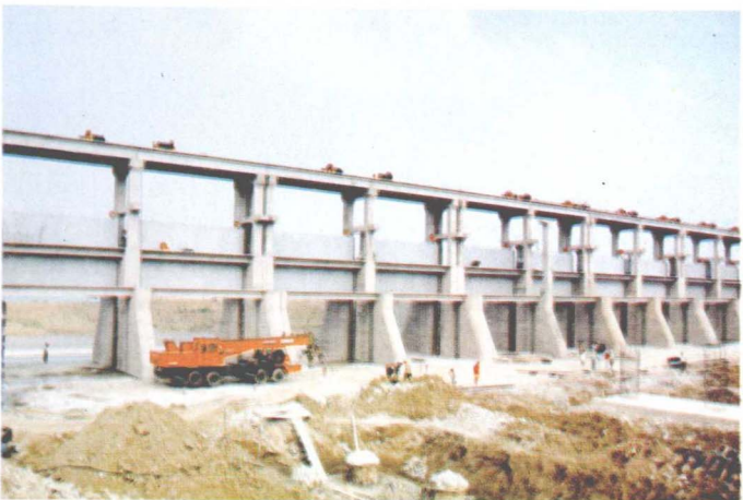
建设中的万年闸节制闸
