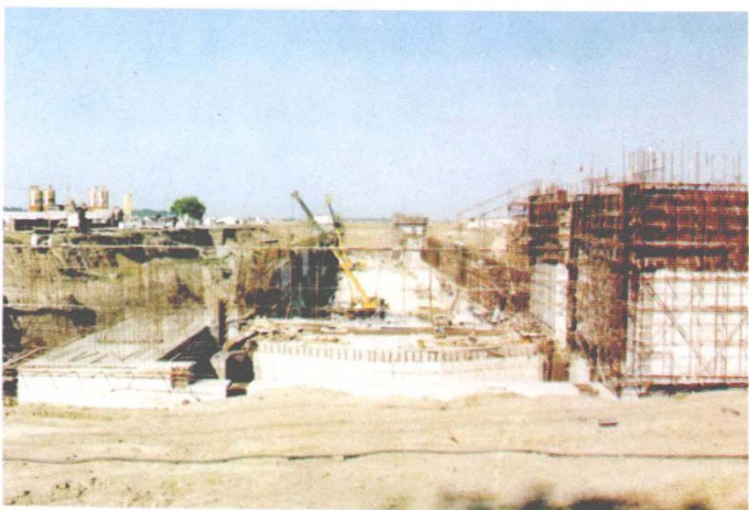
建设中的万年闸船闸
