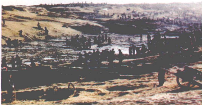
梁济运河疏河工地
