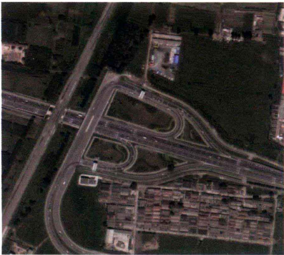
图 1-2 某高速公路两侧空间环境状况(高速公路建设后基本未发生大的变化)
