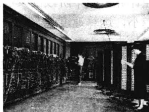
图1-1 世界上第一台电子计算机ENIAC
