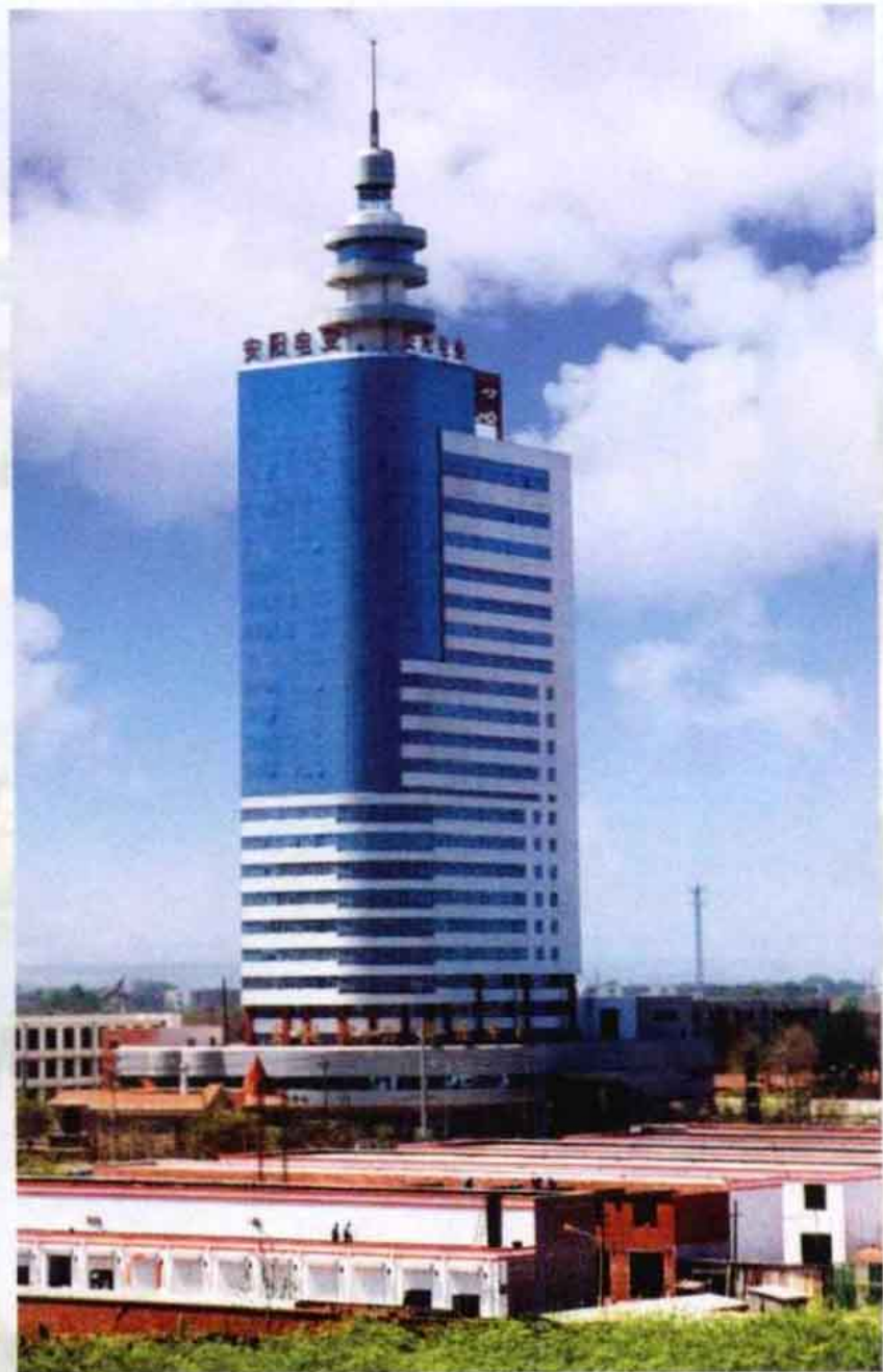
电业局电力调度中心
