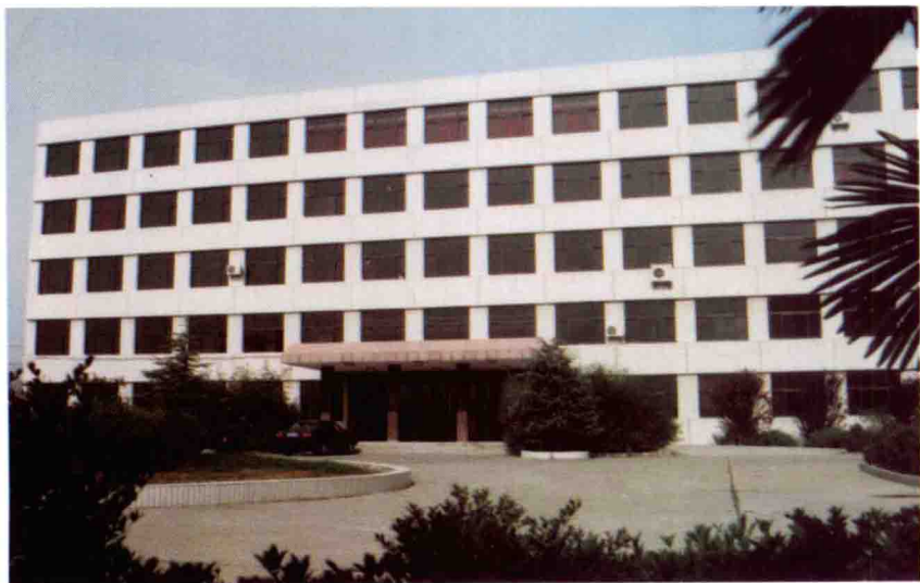
◀ 周口市土地管 理局办公楼外景
