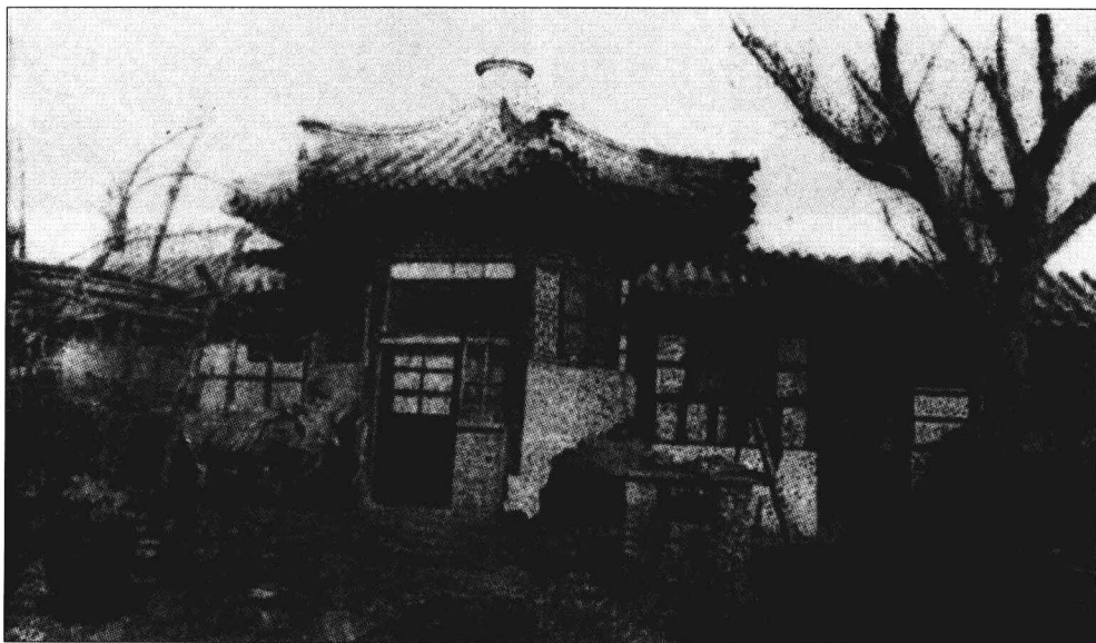
杨椒山祠(谏草亭)原貌
