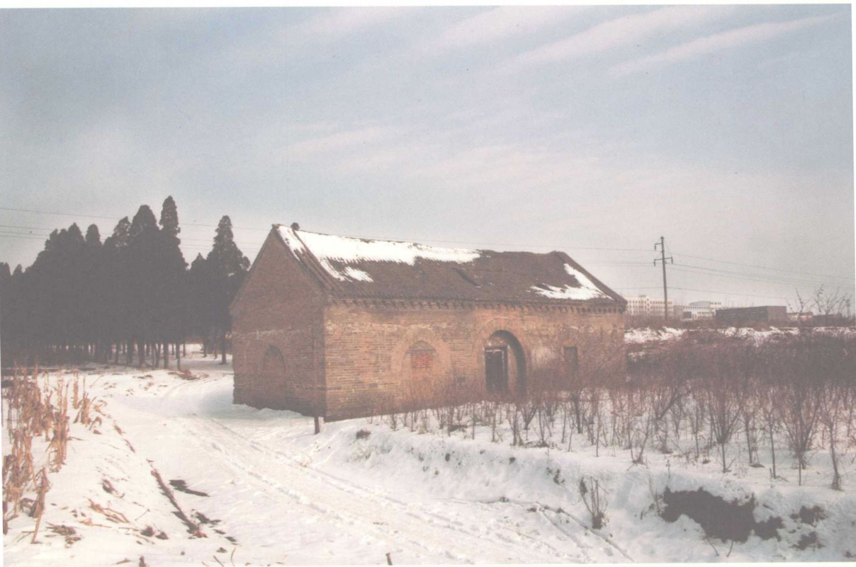
太室阙 （图为太室阙保护房） 地理坐标：北纬 34^{\circ} 27' 06.81'' ，东经 113^{\circ} 04' 04.09'' 。太室阙位于登封东太室山黄盖峰下中岳庙天中阁前600余米处的中轴线上。它是中岳庙前身太室祠前的神道阙，它意外被保存下来，成为中国地表之上最古老的礼制建筑。
