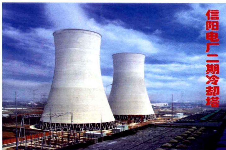
信阳电厂二期冷却塔
