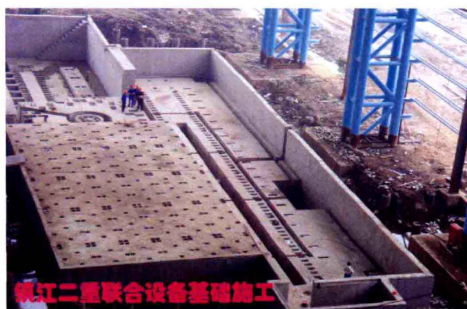
镇江二重联合设备基础施工
