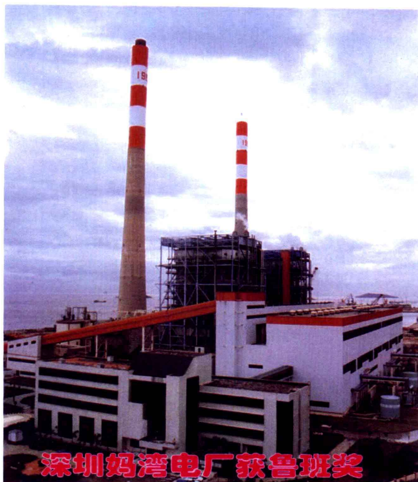
深圳妈湾电厂 2×300MW发电机组 1992年1月-1993年8月承建
