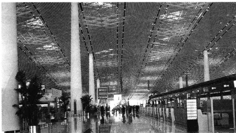
图 1.1.4 首都国际机场 T3 航站楼
