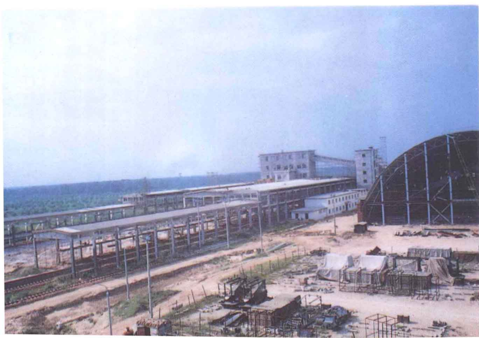
化肥装运站台
