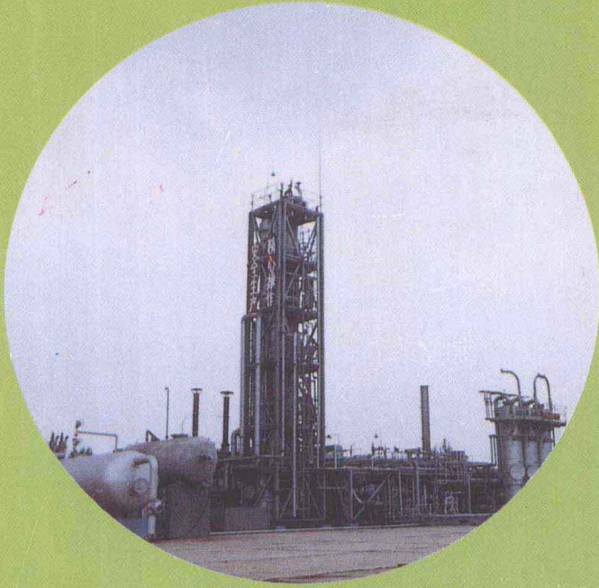
该行支持建成的天然气公司第一气体处理厂 (lpG轻烃回收装置)
