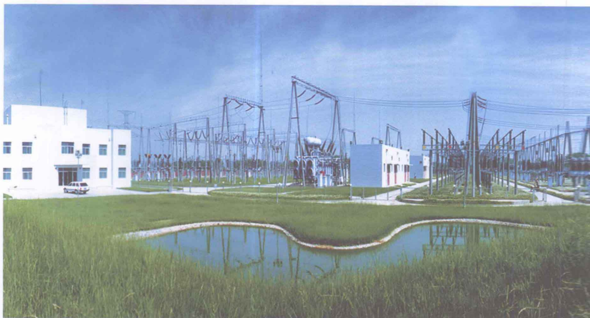
220千伏灵山变电站
