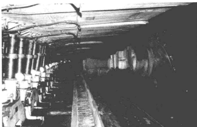
陕西榆林某煤矿的综采现场
