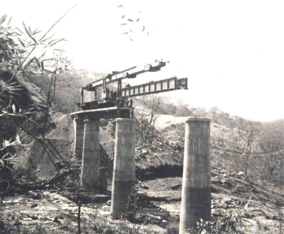
用架桥机架桥
