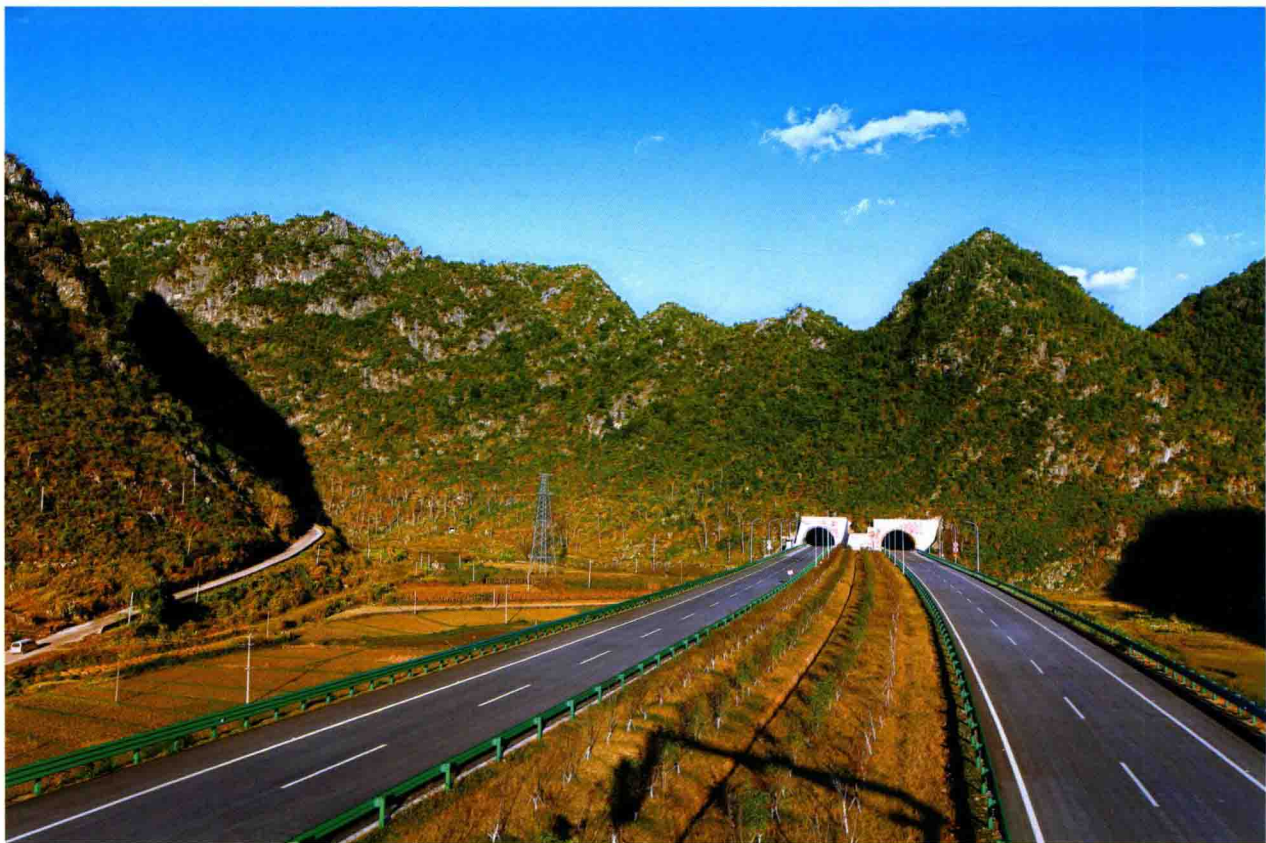
平爱隧道出口
