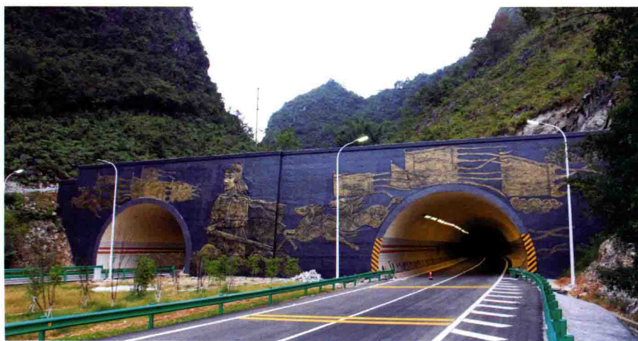
洞邦隧道洞门
