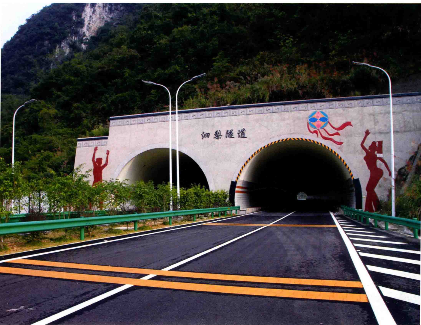
泗梨隧道洞门
