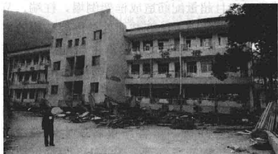
图 1.1-4 汶川地震北川一中五层教学楼只剩下三层
