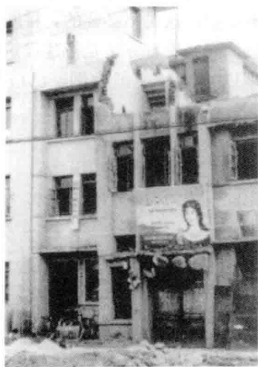
图 1-4 右侧原是四层建筑物因受两旁新建建筑物影响沉降的严重而不得不拆除
