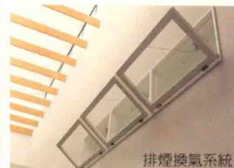
排煙換氣系統
