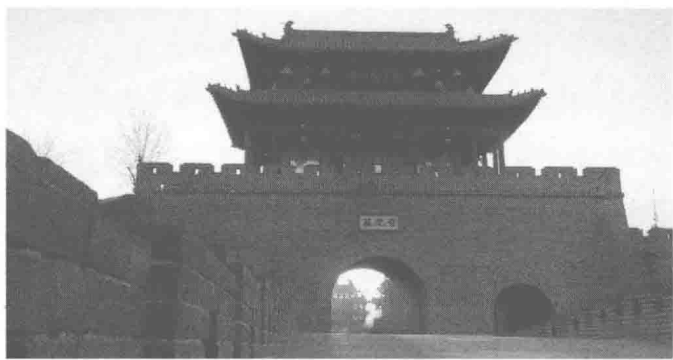
图 1.1 台儿庄古城城门楼。1938 年 3 月至 4 月间，台儿庄这座被称为“天下第一庄”的鲁南重镇，成了房无完房、墙无完墙的废墟焦土，2 平方公里的城区“无方寸之土不沃血”。2009 年，古城重建拉开序幕。重建后的台儿庄古城与华沙成为世界上仅有的两座因“二战”炮火毁坏而作为世界文化遗产重建的城市。
