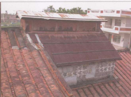
圖1-6：小屋頂，兩側共開六扇天窗作為排氣使用。凹下/吳屋/1950年建。
