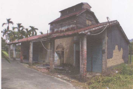
圖1-2：擁有密閉的烤菸室，透過熱氣燻烤菸葉的菸樓。 茅窩/傳屋/1950年建。
