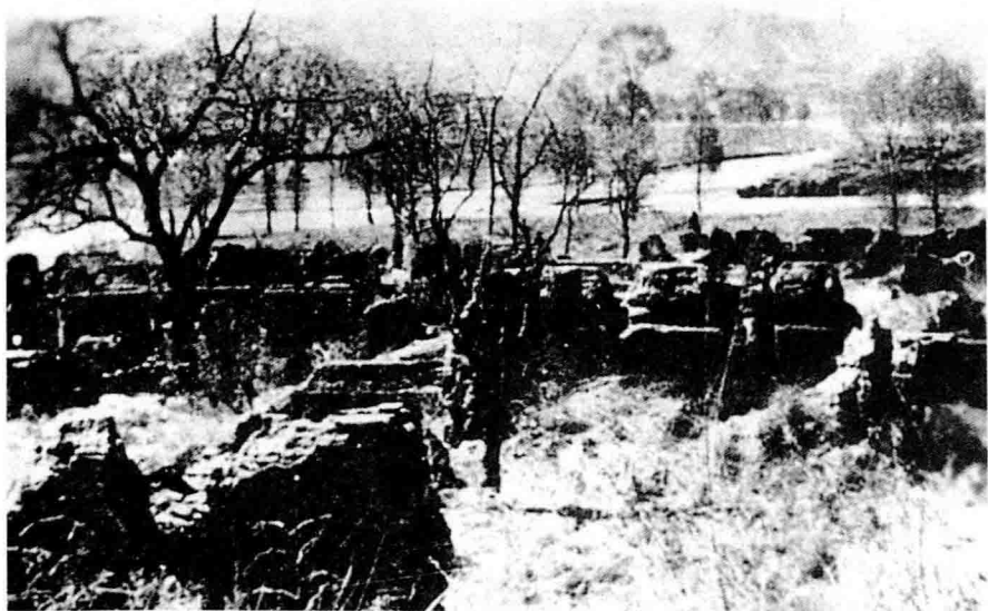
被日军烧杀后的河西村断壁残垣，一片瓦砾
