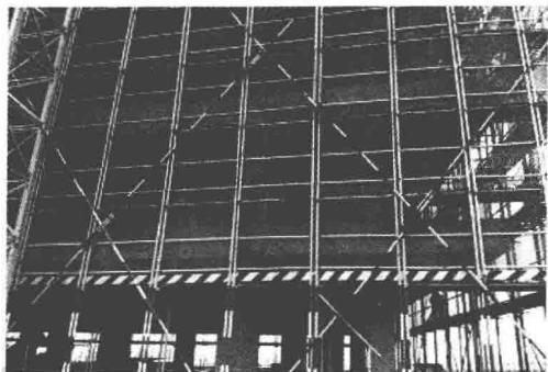
图 1.12 扣件式钢管脚手架
