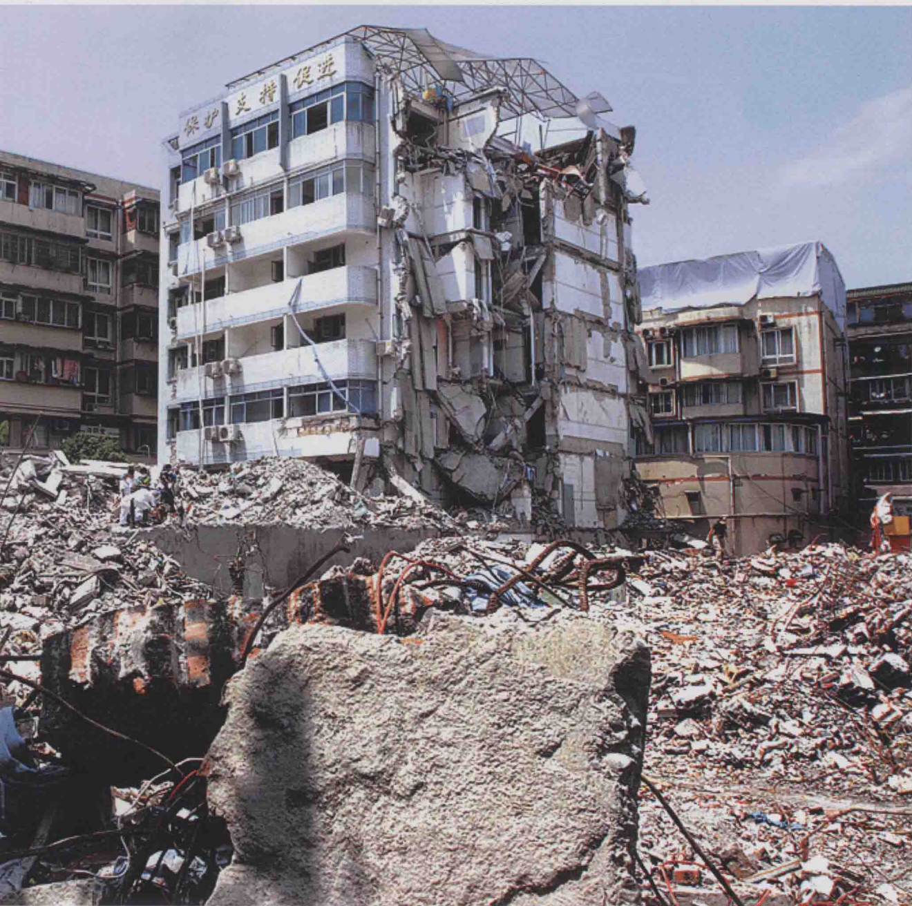
都江堰市公共建筑损毁现场
