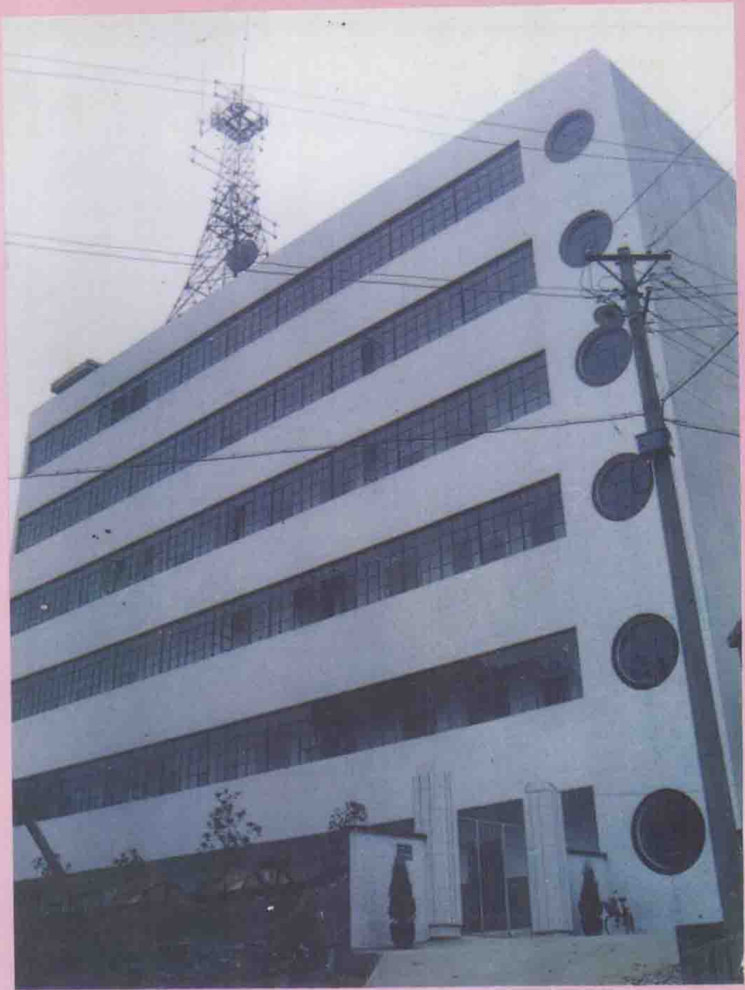
一九九四年五月投产使用的综合电信大楼
