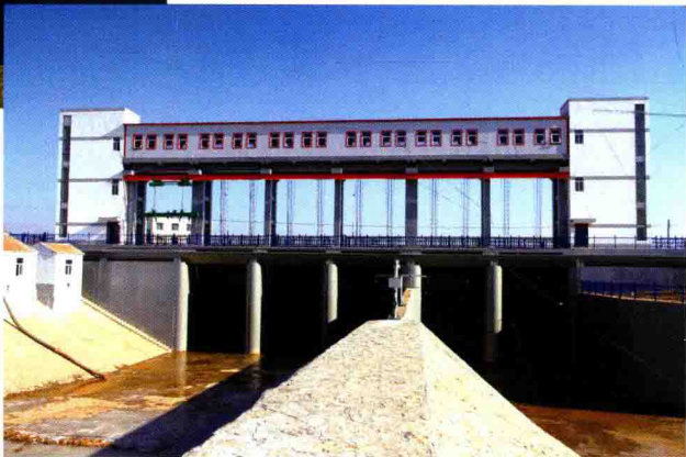
竣工后的牛角峪退水闸——五孔闸
