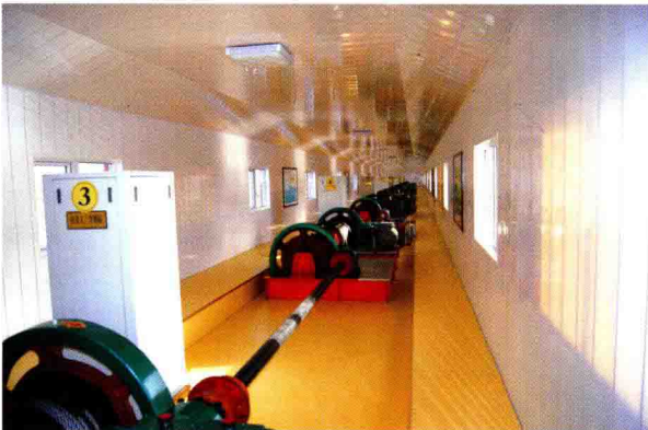
王营盘闸启闭机房（马建飞 摄）
