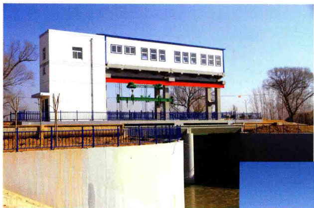
竣工后的牛角峪退水闸——二孔闸
