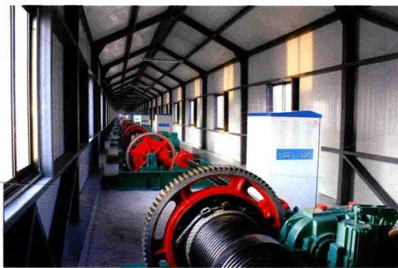
庆云闸启闭机房（李国兴 摄）
