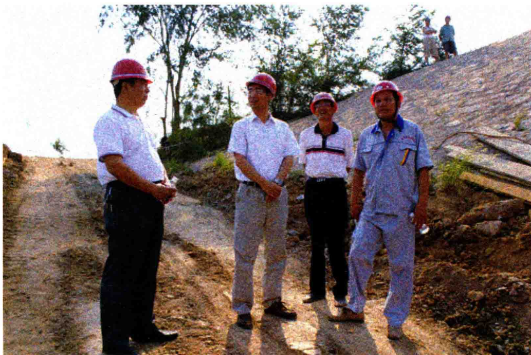
7月4日 漳卫南局副局长靳怀堵（左2）到牛角峪除险加固工程建设工地慰问参建职工
