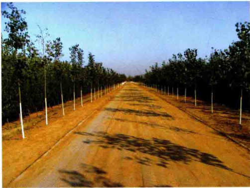
临清堤顶路面
