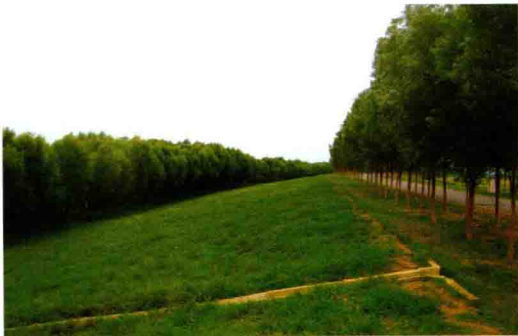
盐山河务局堤坡及防浪林
