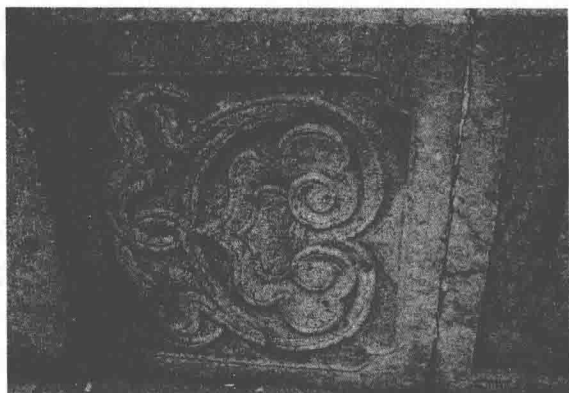
图4：浙江绍兴太平桥引桥护栏板
