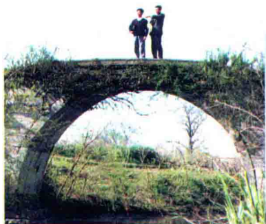
漾西镇胡湊村大古 环桥(广福桥又名友 谊桥)建造于明朝
