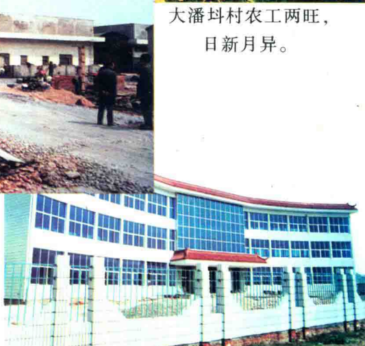
大潘垈村新建办公大楼。
