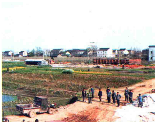
正在建造的漾西镇乔湊文化村从 1995 年元 月至 1997 年 12 月完工,已投资 6 千万元
