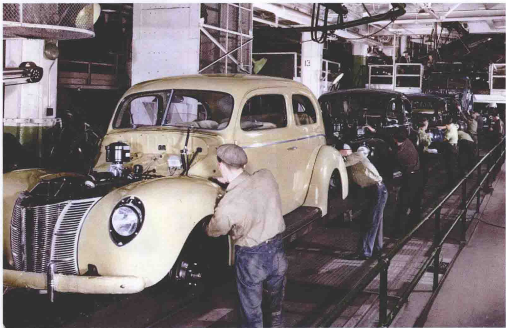
图1-1 1940年生产福特汽车的流水线
