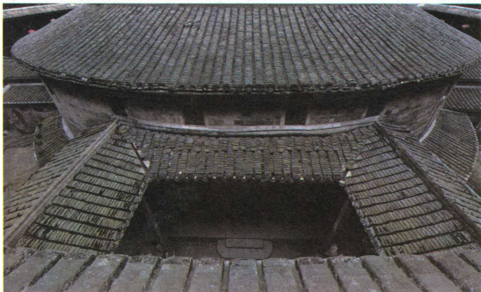
福建南靖土楼
