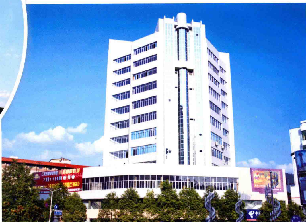
仁怀电信大楼 (2005年9月摄) (图25)
