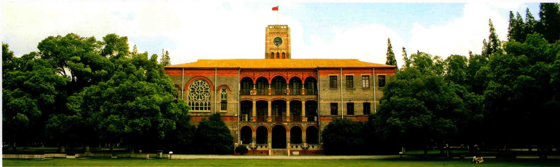
钟楼南面全景 South View
