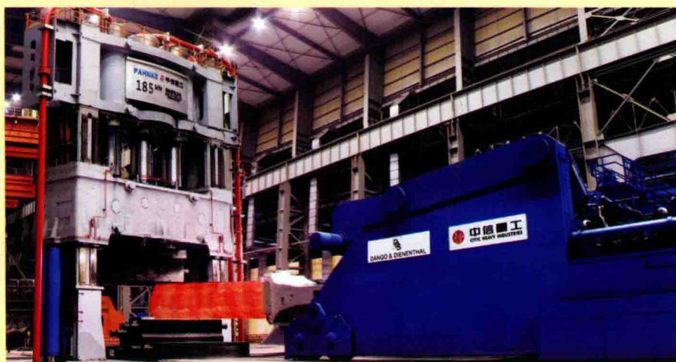
秉承焦裕禄精神，中信重工全力打造以 18500 吨自由锻造油压机为核心的新重机工程
