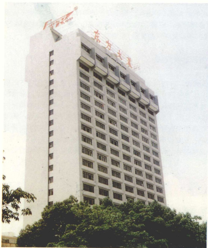
汕尾駐深辦事處大樓 十五層 深圳市東門中路 36 號
