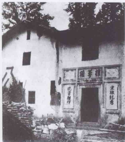
青溪交通站秘密仓库之一：大水坑棣萼楼
