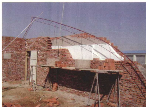
图 2-7 温室东、西山墙的建造
