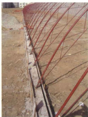
图 2-8 前底脚浇筑地梁
