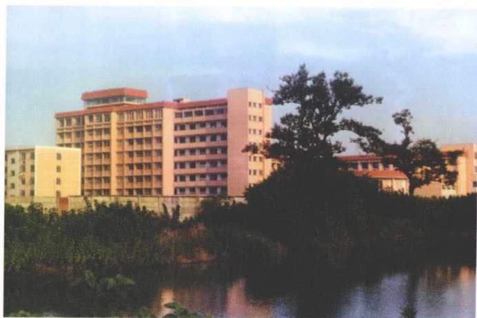
▲ 第一期建设工程完成
