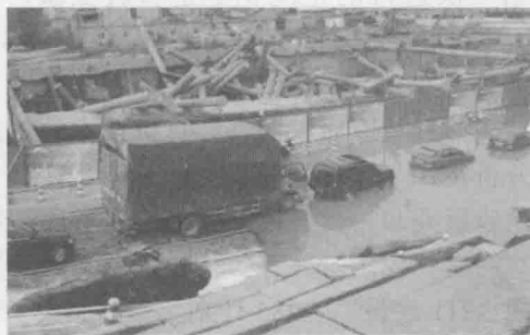
图 1-2 杭州地铁坍塌事件
