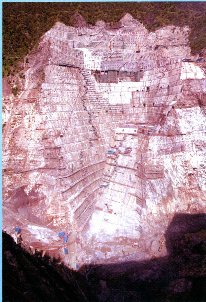
左岸边坡开挖支护全景
