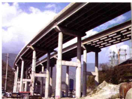
中环公司承建的雅泸高速工程栗子坪大桥
