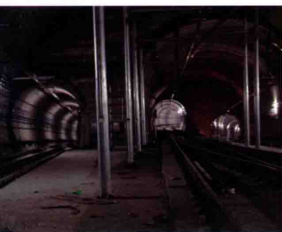
三个断面组成的大断面
