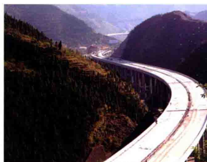
广陕楼房沟特大桥
