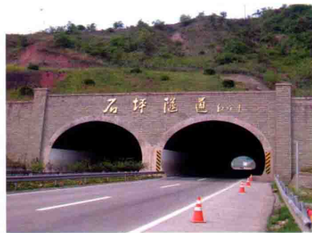
中环公司建成的渝邻高速公路石坪隧道
