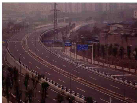
大庆村立交桥
