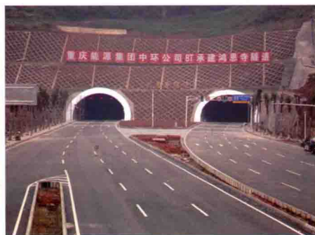
中环公司承建的重庆市嘉华大桥北延伸段洪恩寺隧道
