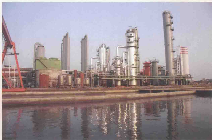
湖北三宁化工污水晾晒池
