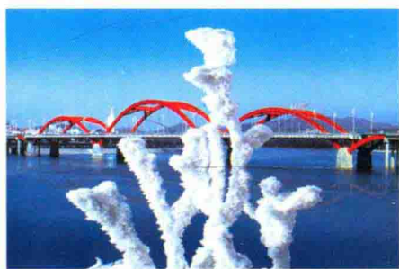
▲ “永安石”传说的地方建起了彩虹桥
