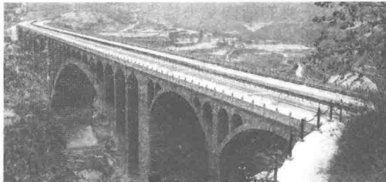
b) 晋城至焦作高速路上的特大跨径(主跨146m)石拱桥——丹河大桥
