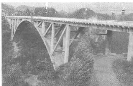
a) 遵义市仁怀盐津河大桥——桁架拱桥
