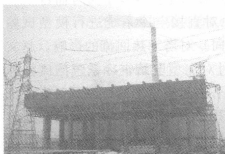
图 1.4 大唐国际云冈热电厂 2\times 200\text{MW} 直接空冷机组
