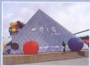
深圳世界之窗工程
